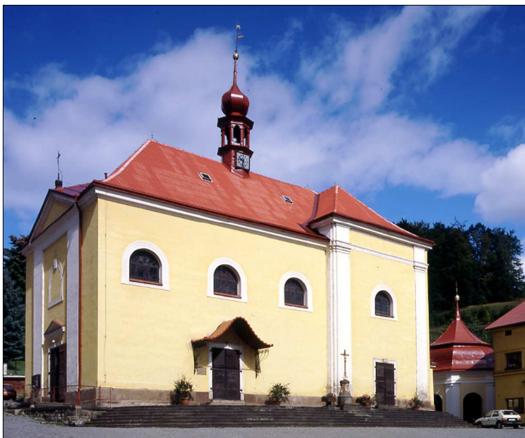
Kostel Sedmi radostí Panny Marie v Malých Svatoňovicích
