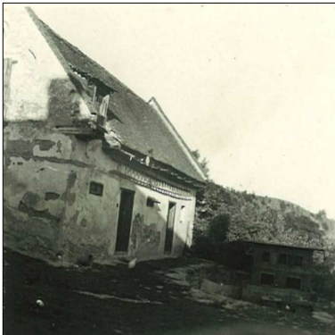
Chlív před opravou
